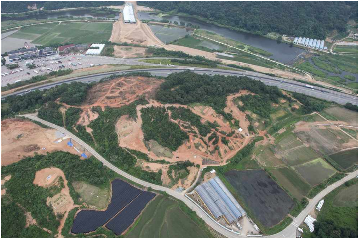
[사진 2] 조사 후 전경
